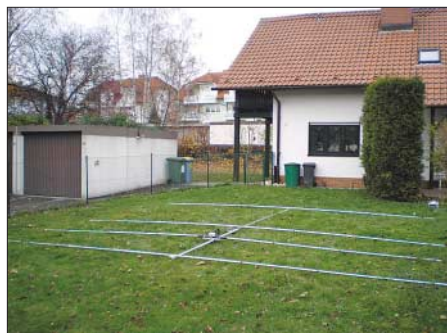
Bild: 13 Der von DL1NUX und DO3NBW aufgebaute 15-m-Beam vor der Montage
