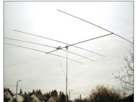
Bild 14: Der 15-m-Beam von DL1NUX und DO3NBW nach der Montage Fotos: DK7ZB (5); DL1NUX (2)
